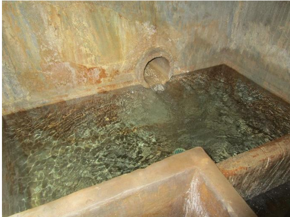
Abb. 4.3: Brunnenstube Guggenloch Süd (Foto L&H 3.10.2018)
